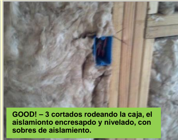
BIEN! - Encrespado y nivelado contra el marco
