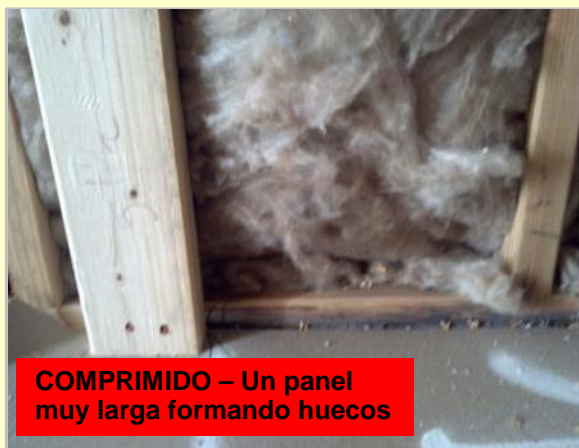
COMPRESO – 1 or 2 cortadas y bulgs visibles
