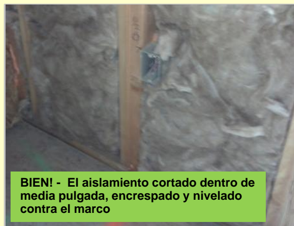
GOOD! – 3 cortados rodeando la caja, el aislamiento encrespado y nivelado, con sobres de aislamiento.
